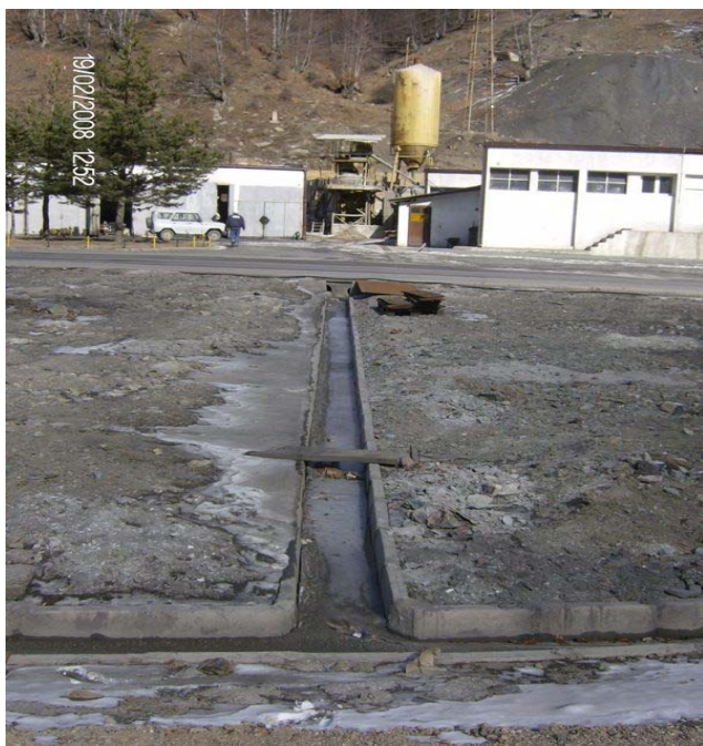
Сл.3 Таложник кај бетонска база и приклучок на атмосферски канал
