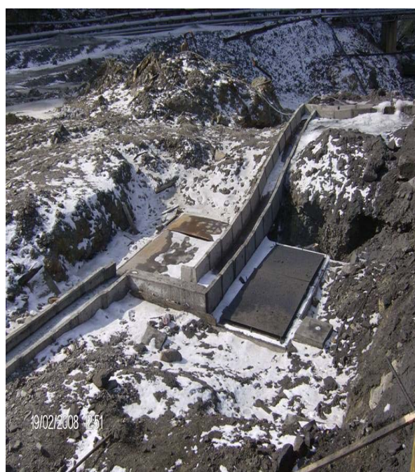
Сл.4 Таложник за сепарација на вода и масло, атмосферски канал и краен таложник пред испуст во реципиент
